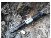
Puis le sectionnement : les agents ferment les vannes jusqu'à ce que le bruit disparaisse, ce qui permet de localiser précisément la fuite.
