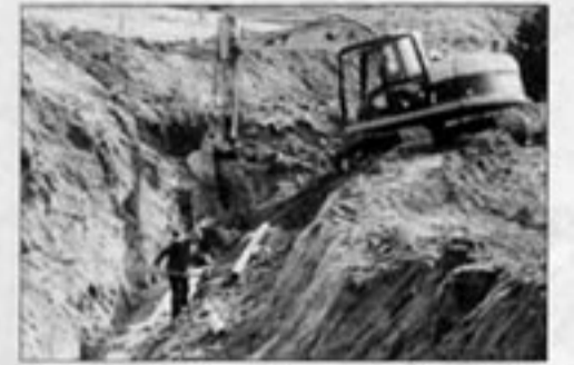
Par crainte d'être confronté à une pénurie d'eau, l'aubergiste réalise actuellement de nouveaux travaux.
